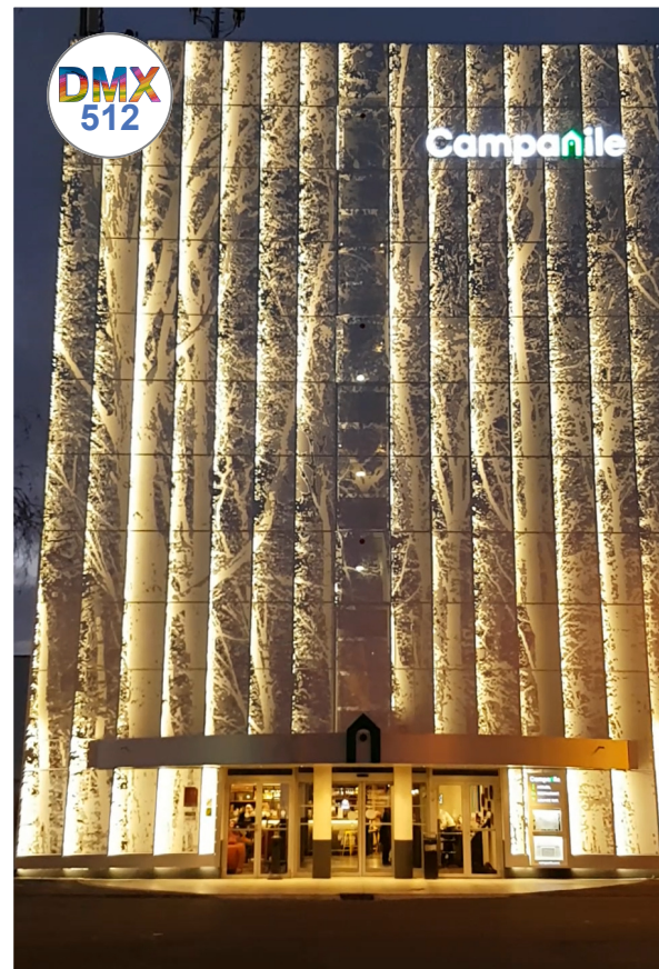
Pilotage DMX d'une façade d'un hôtel.
