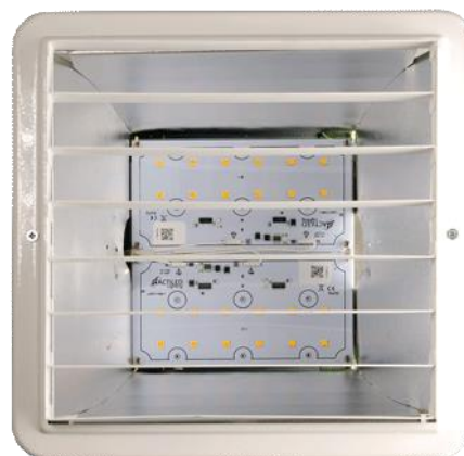
Exemple de retrofit avec un Kit LED 60W
